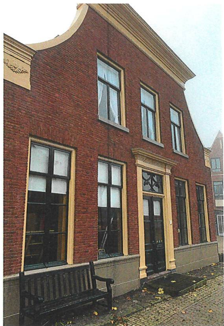
Restauratie oogt Huize Keizer rustig door de rode voegen en harmonisch schilderwerk
